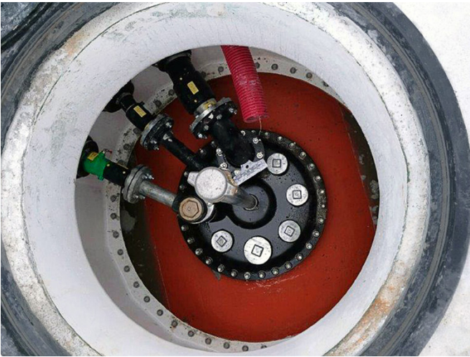
İç ve dış borular arasındaki geçiş boşluğunun kontrolü ve izlenmesi, ekstra bir güvenlik katmanı sağlar
